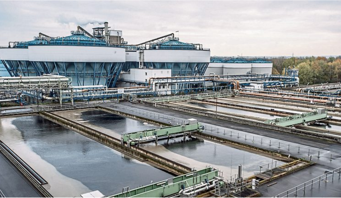
Tanks, in denen Löschwasser aufgefangen kann, gibt es nur im Klärwerk, nicht am Ofen. Eine Schwachstelle, so der BUND. Foto: Ralf Krieger
