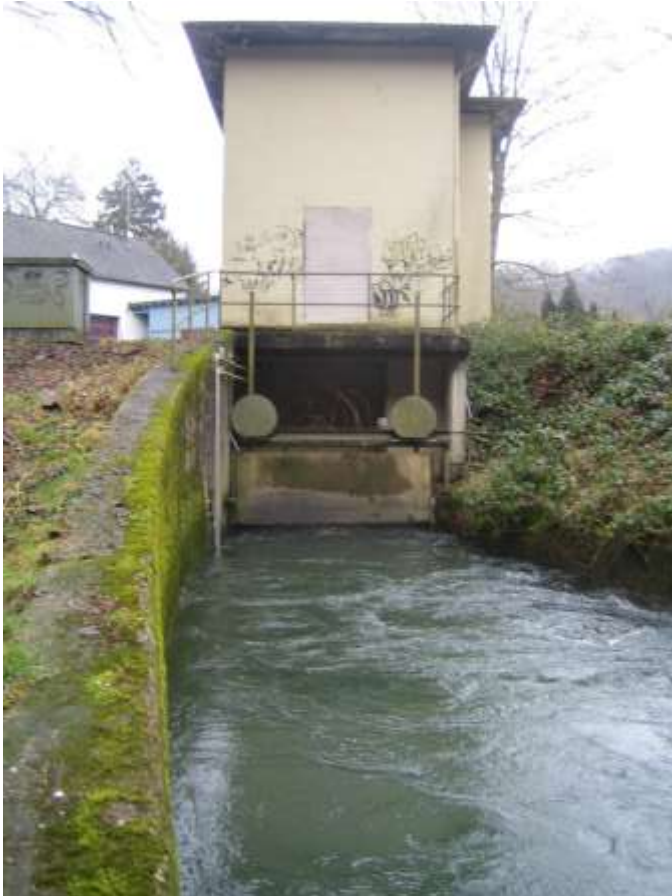
Turbinenhaus aus dem der Turbinengraben tritt. Hier sollten die Aggerkraftwerke eine Einschwimmsperre bauen. Diese kam, wie auch die Durchgängigkeitshilfe, nicht zustande und die Stauerlaubnis war weg.
