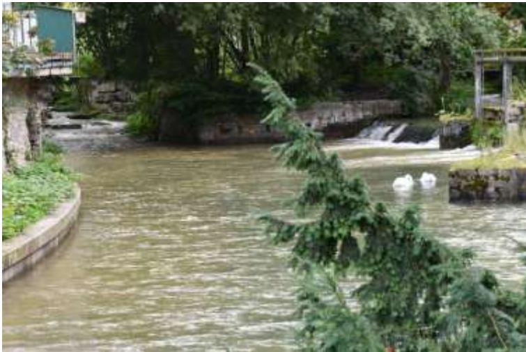
Bild3: Die Fische können durch das Gerinne (links) an dem durch das von der Stümpelschen Mühle (rechts) versperrten Gerinne vorbeischwimmen. (Reinhard Schäck)
