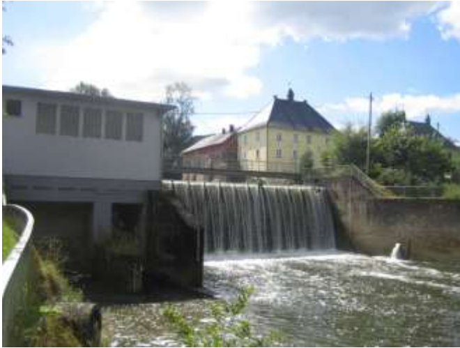
Die Wasserkraftanlage Haus Ley ist außer Betrieb. Das Wasser fließt über das Wehr. (F. Meyer)
