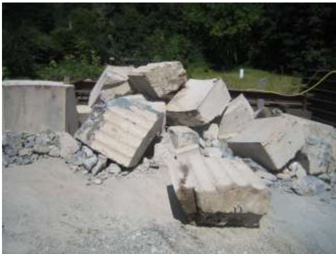
Trümmerreste des ausgebauten Turbinenfundaments (F. Meyer)
