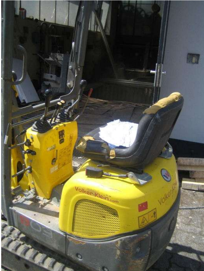
In das Loch (hinten) soll die neue Turbine eingebaut werden (F. Meyer)
