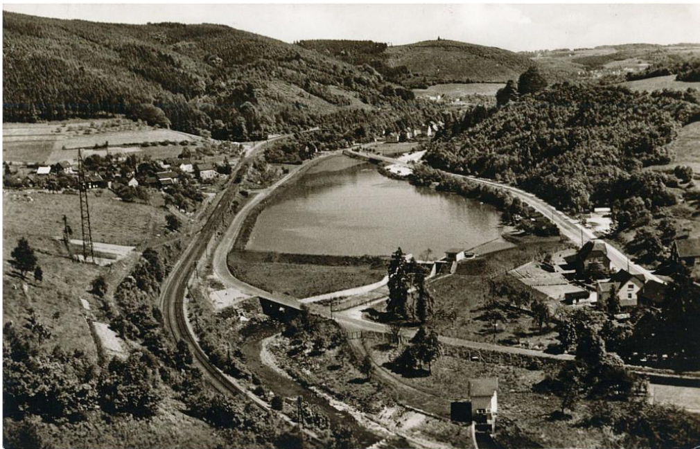
Postkarte vom westlichen Teil des Staus Osberghausen im Jahr 1962. Unten das Turbinenhaus, zu dem das Wasser aus dem Stau unterirdisch abgeleitet wird.
