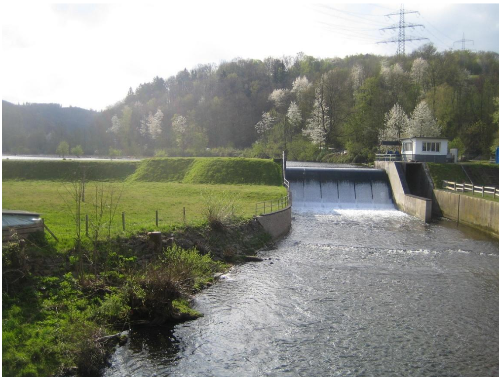
Die neue Wehranlage des Staus Osberghausen im April 2022.
