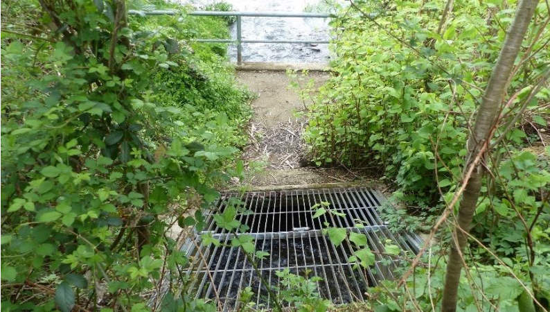
Westerbach Tunnelaustritt in die Sieg
