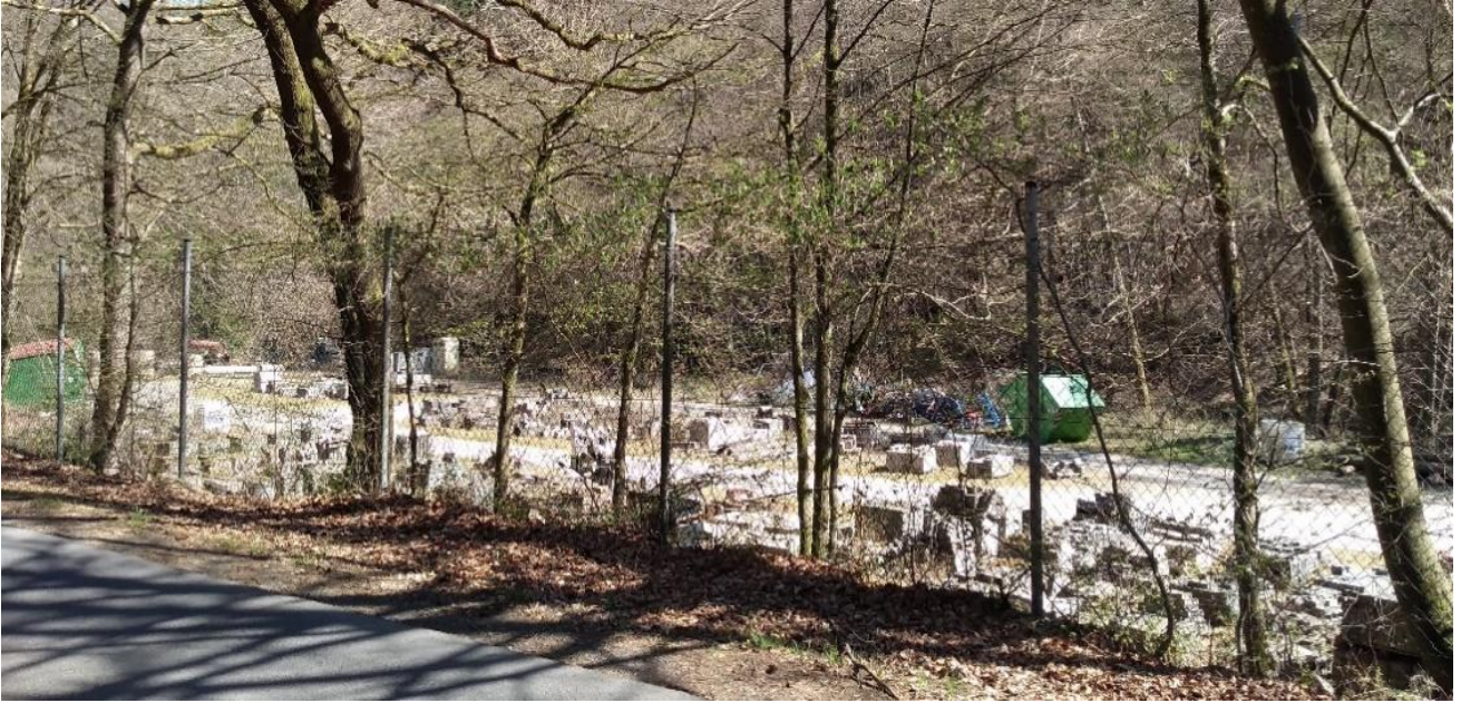
Bachau des Hufener (Gierzhagener) Baches wird als Lagerplatz des Bauhofes genutzt
