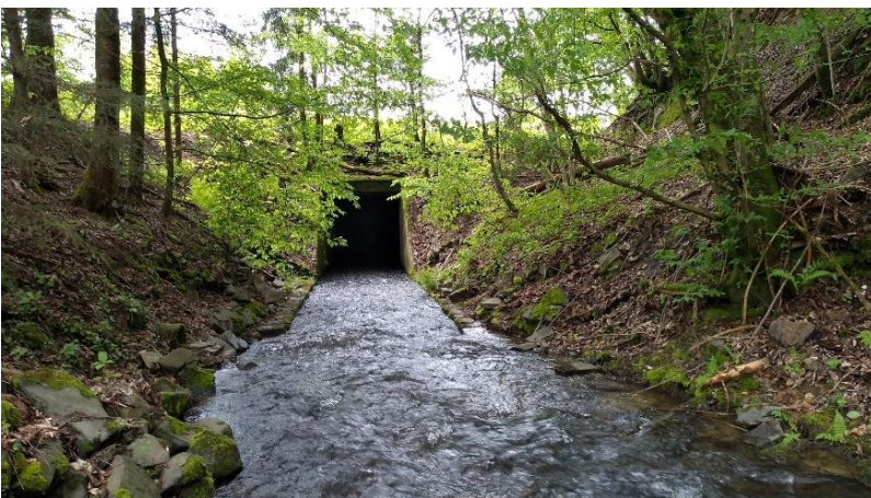
Westertbach Tunneleintritt (55m) unter Präsidentenbrücke
